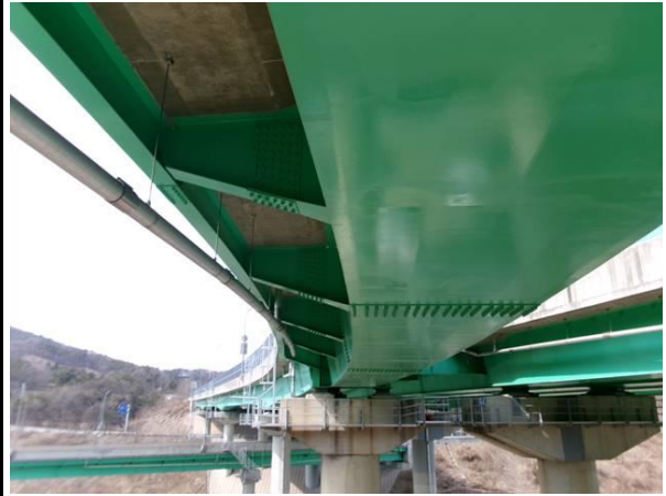
궁촌IC RAMP-B교 상부구조 전경
