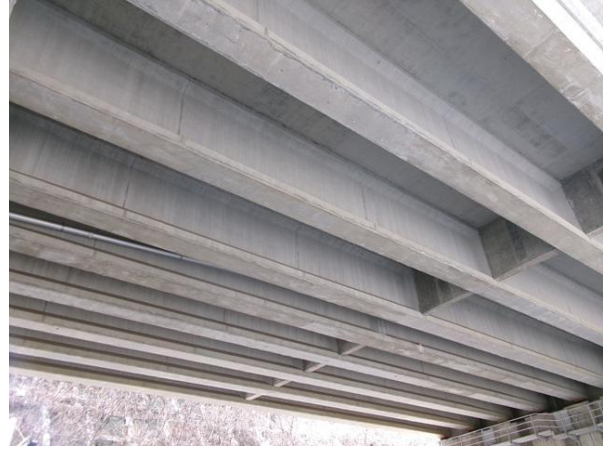
두교2교 상부구조 전경
