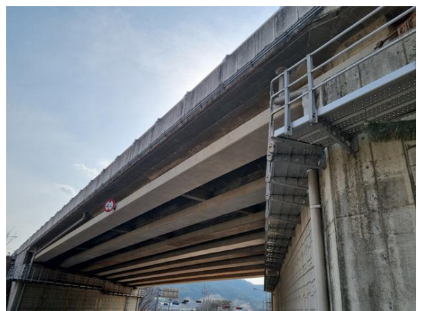
청안2교 상부구조 전경
