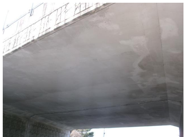
강천육교 상부구조 전경
