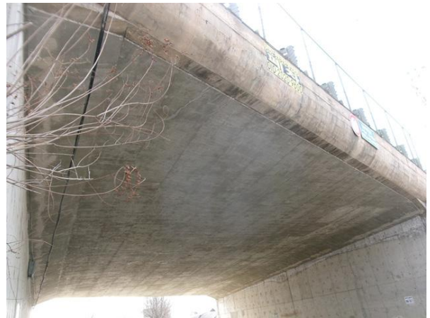
능서육교 상부구조 전경
