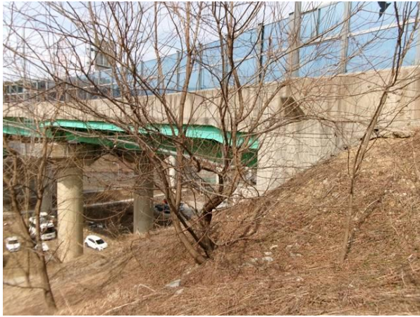
궁촌IC RAMP-B교 측면전경
