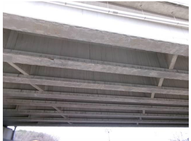
신기1교 상부구조 전경
