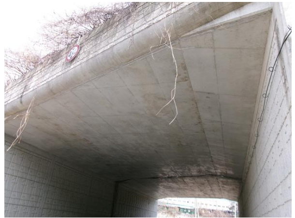
두교4교 상부구조 전경
