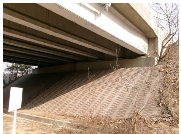
안터교 상부구조 전경
