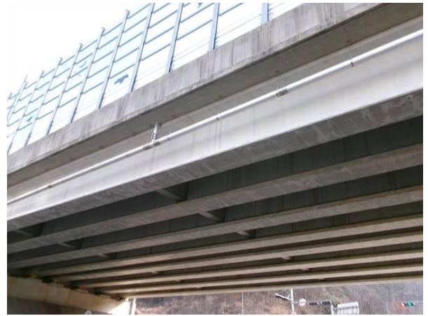
역동교 상부구조 전경
