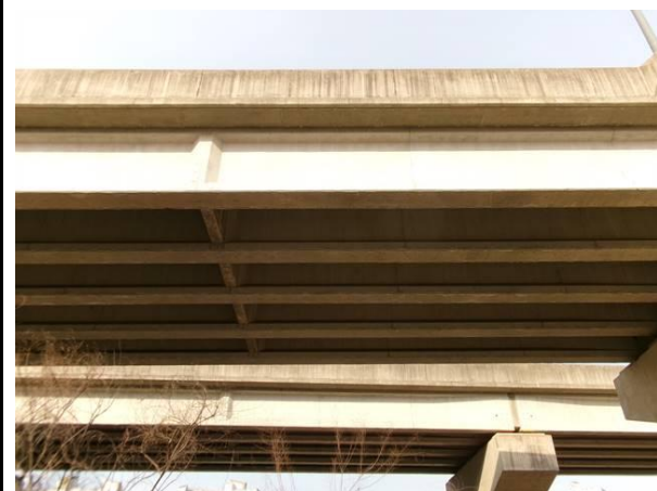
궁촌1교(하) 상부구조 전경
