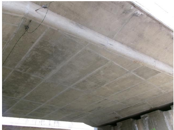
오천교차2교 상부구조 전경
