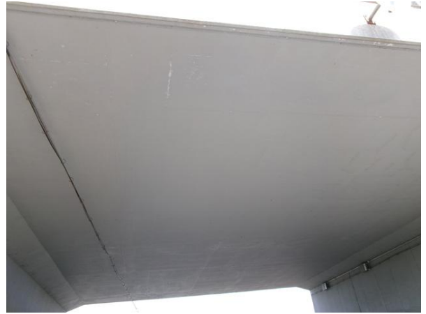
고안육교 상부구조 전경
