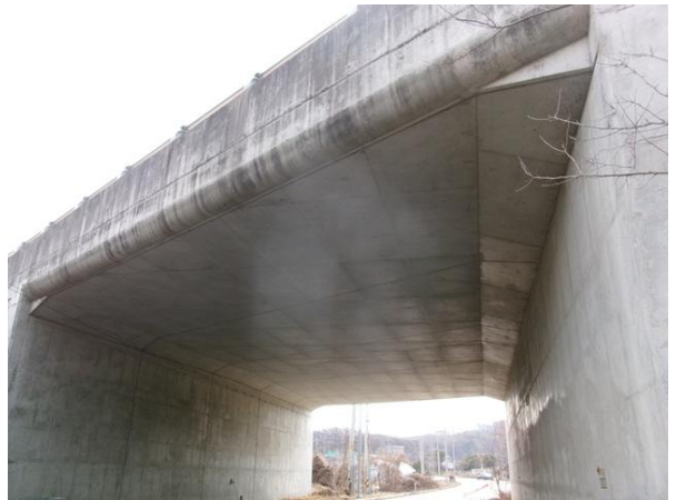
선돌교 상부구조 전경
